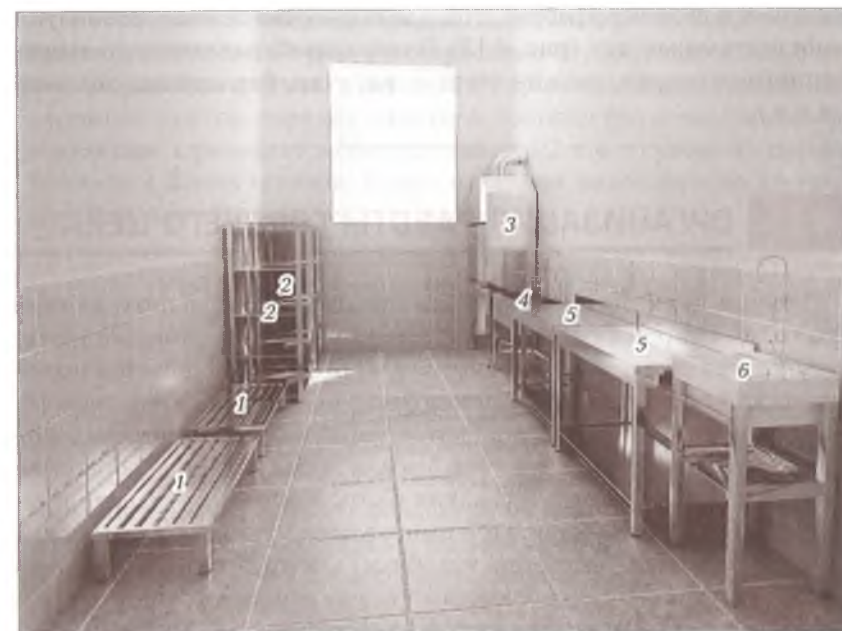
Рис. 4.13. Техническое оснащение цеха обработки зелени:
